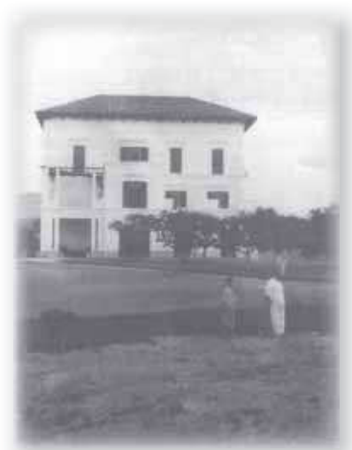
Villa in costruzione (si notino gli infissi e il piazze non ancora ultimati).
